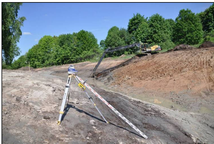
13 pav. Musėje akmenų kliūtis geriausiai montuoti ant kranto stovinčiu ilgastreliu ekskavatoriumi
